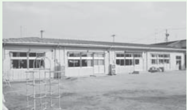
▶老朽化が著しい保育所の建て替えと、幼保の一元化を（北口保育園）
