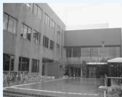
▲耐震性が低く、早急に建て替えが必要な久居市民会館
