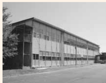
▲経年劣化が著しい南が丘小学校のプレハブ教室
