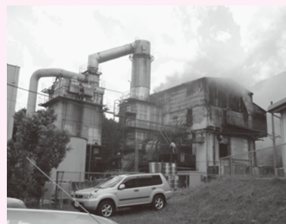
▲平成24年9月12日、火災で黒煙を上げる長谷山の産廃施設
