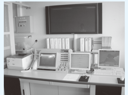
▲本庁8階に設置されている津市地域防災情報通信システム
