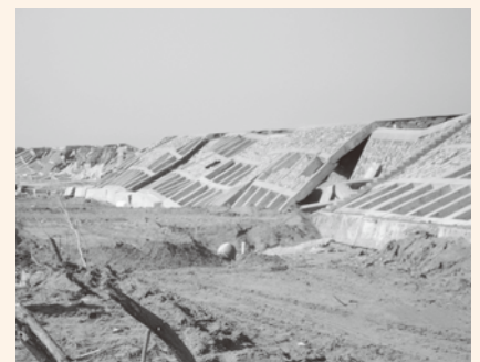
▲東日本大震災の津波により破壊された堤防
