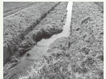
▲土砂が堆積し、補助事業による改修を待つ排水路
