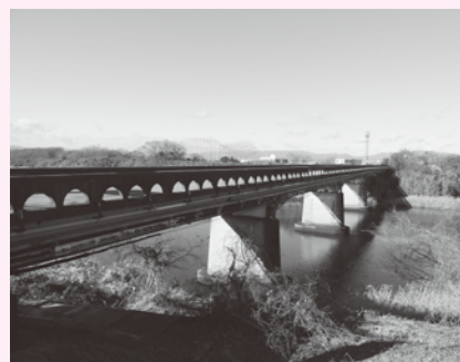
▲老朽化に伴い早期の架け替えが望まれる香良洲橋
