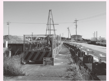
▲改修のため地質調査が進む白塚地区の海岸堤防
