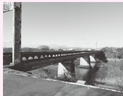
▲老朽化が進み、早期の架け替えが望まれる香良洲橋
