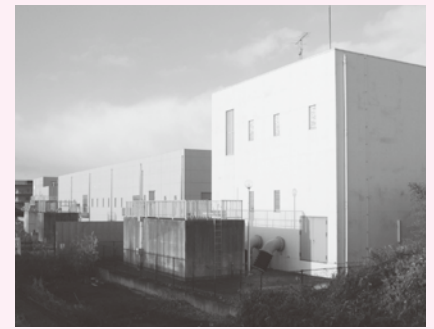
▲平成30年4月供用開始に向けて工事が進む汚水処理施設
