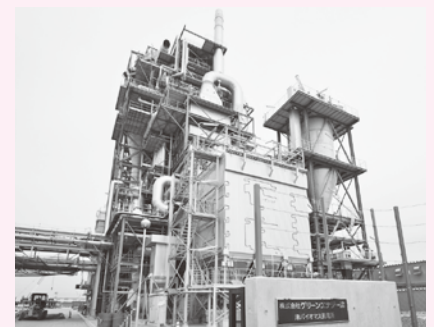
▲バイオマス発電が始まった株式会社グリーンエナジー津
