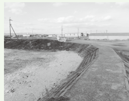
▲早急な改修が求められる海岸堤防
