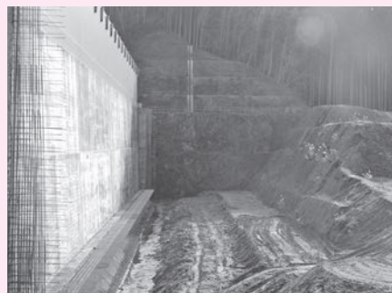
▲1期工事完了後も長らく放置されている大きな穴と鉄筋
