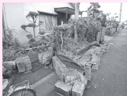
▲熊本地震によるブロック塀の倒壊
