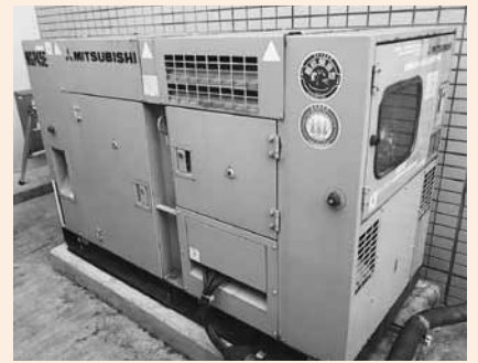
▲施設に応じた十分な非常用電源設備を
