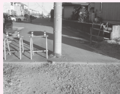
▲地主の協力により拡幅した道路部分だけでも通行可能に
