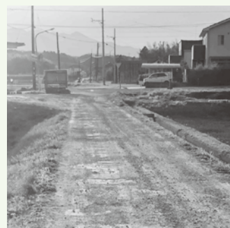
▲市道において生活道路はすべて舗装を
